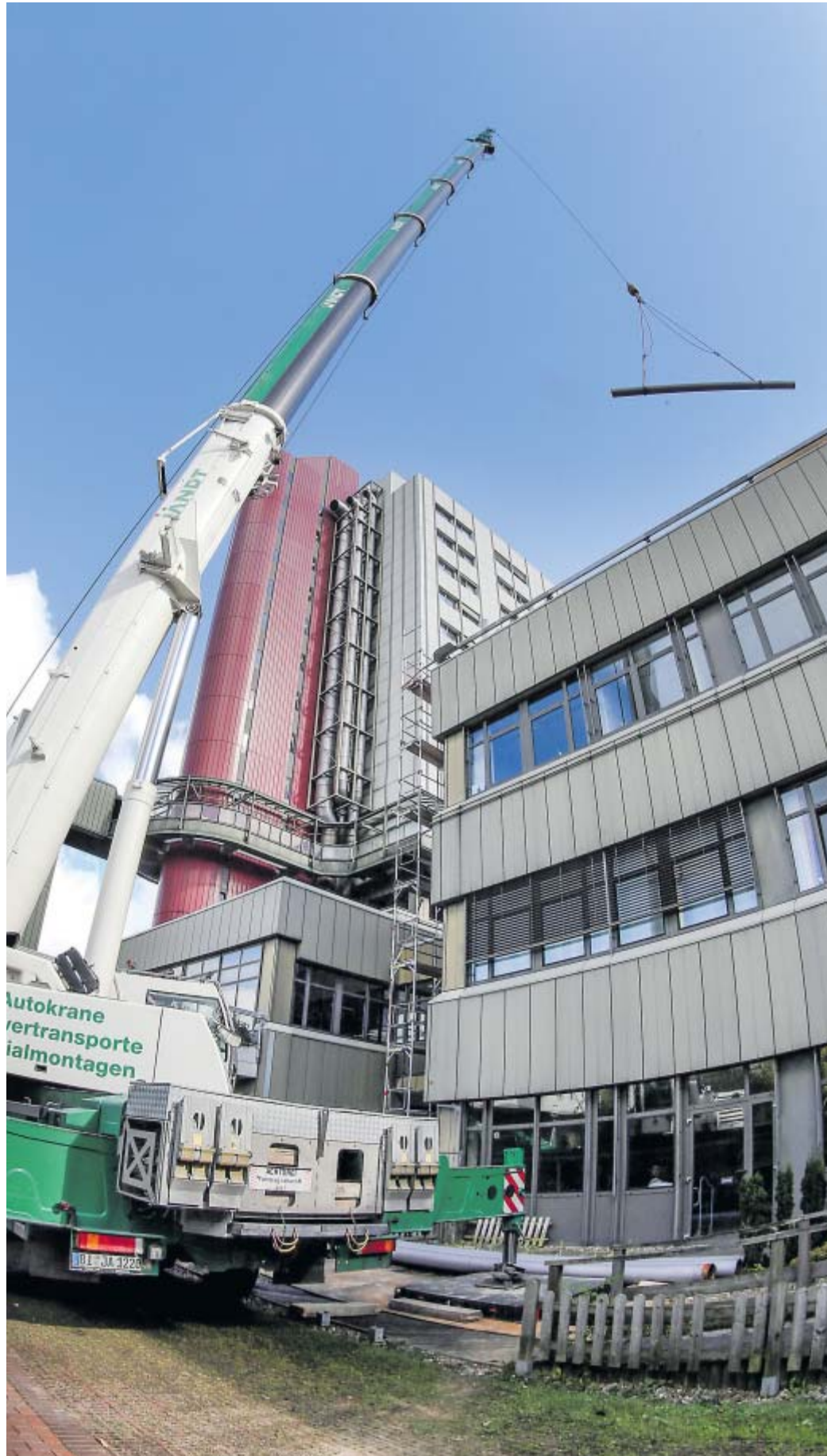
Per Kran: Unter anderem Rohre für die Kaltwasserversorgung werden auf das Dach des Krankenhauses gehoben. FOTO: WOLFGANG RUDOLF
