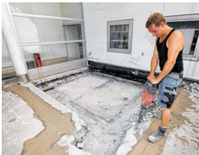
Mit dem Presslufthammer: Philipp Niemeier muss den Bodendeckel wegstemmen, damit die neue Kälteanlage angeliefert werden kann.
